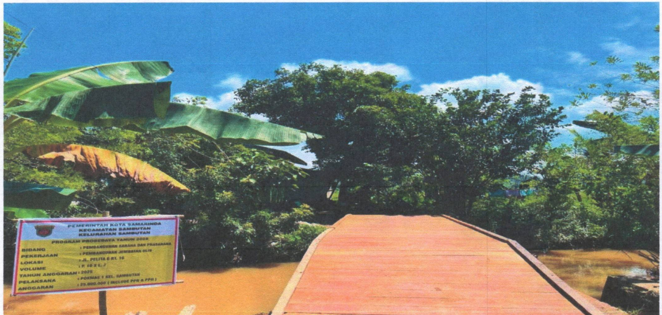
PEMBUATAN JEMBATAN 100% RT 16 POKMAS 1 SAMBUTAN
